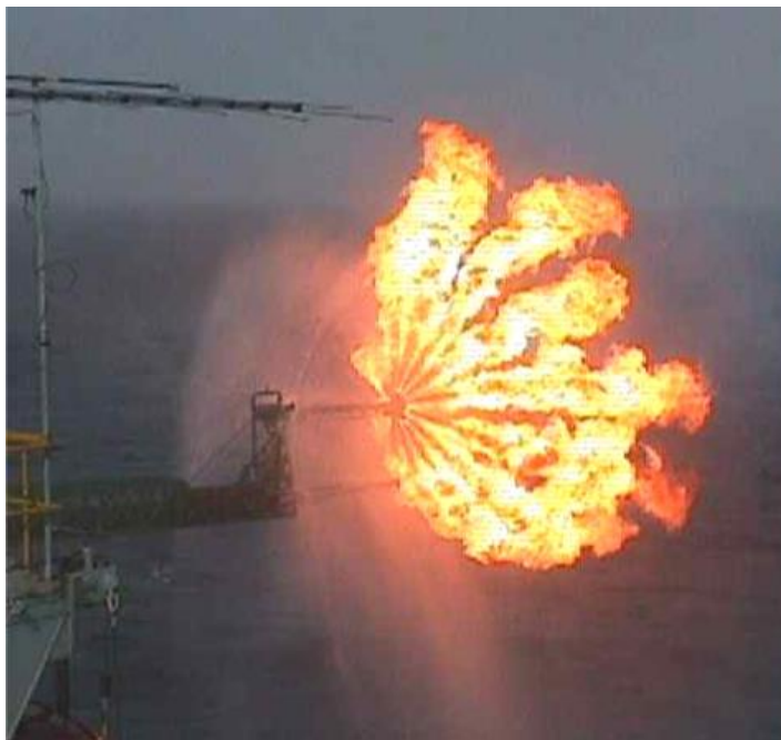
Рисунок 5.1 – Водяной защитный экран факельной горелки
