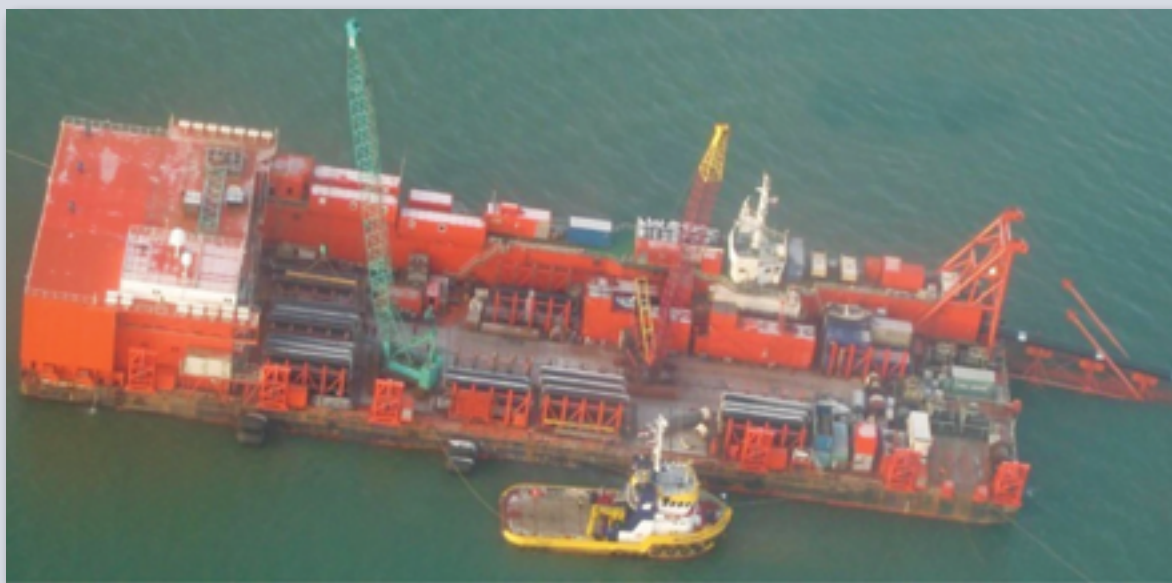
Рис. 2. Трубоукладочная баржа с криволинейным стингером МРТС «Дефендер»
