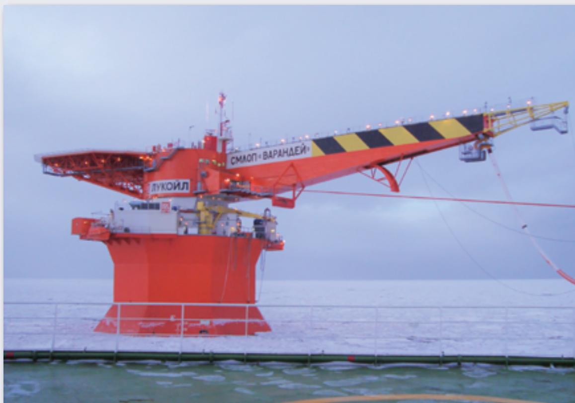
Рис. 1. Первый стационарный нефтеотгрузочный причал на арктическом шельфе
